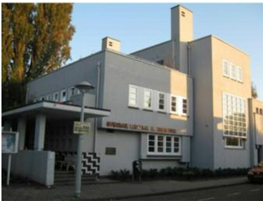
Afb.1 Openbare leeszaal in Betondorp, Van Lochem en Greiner, 1923. Foto na de renovatie.
